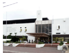
高槻市総合体育館
